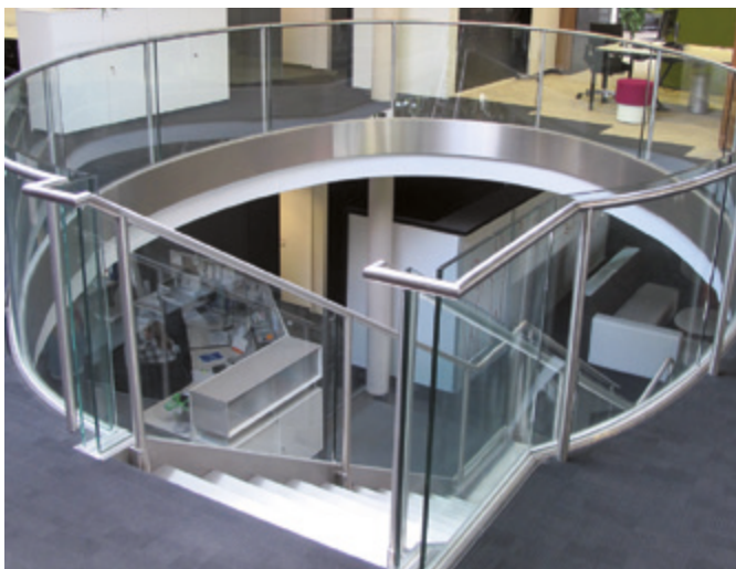
Jednostranně upnuté skleněné parapetní zábradlí
