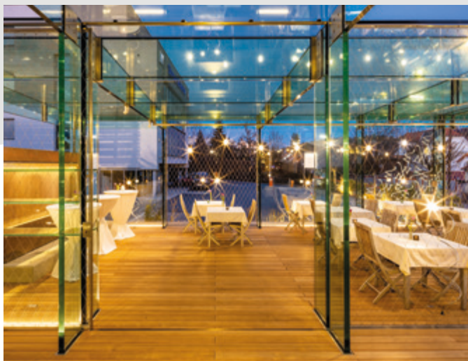
Travi in vetro con funzione portante
